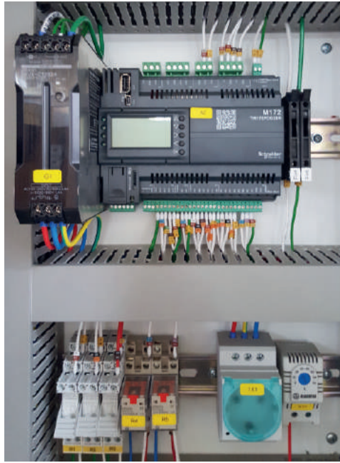
THNS serisi santrallerde kullanılan programlanabilir kontrol paneli
